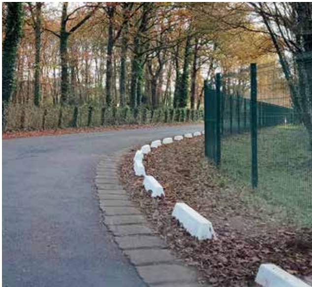
Bordures de défense Route de Fontenaille
