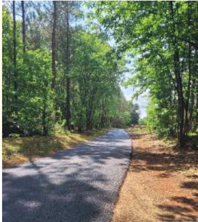
Réfection de la rue du Joubertier pour la partie située entre la sortie du bourg et le chemin de la Prêle.
