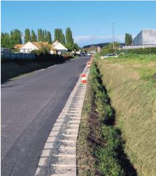
Pose de rives béton de la rue du Soleil jusqu'à l'intersection avec la Route du Parc pour préserver le fossé.
