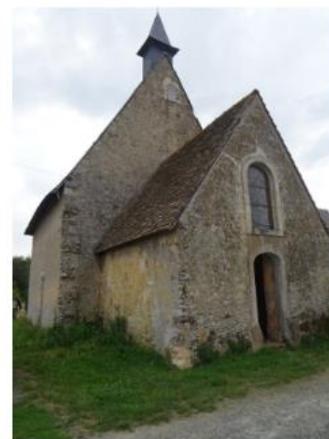
Chapelle Notre-Dame de l'Épine En cours de protection
